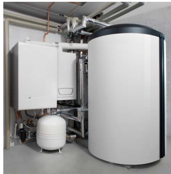
Abb. 7: Mit Brennstoffzellenheizgeräten lassen sich höhere Wirkungsgrade erreichen als mit motorischen KWK-Anlagen
